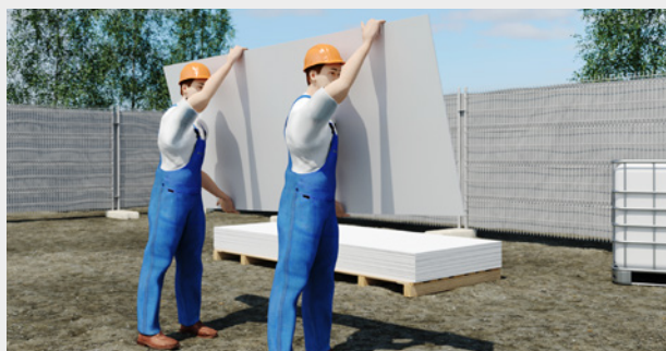
Hardie® Panel och Hardie® Architectural Panel fasadskivor ska alltid bäras på högkant.
